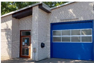
Befestigung am Feuerwehrhaus
